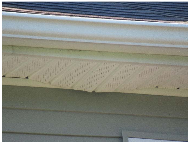
Loose soffit
